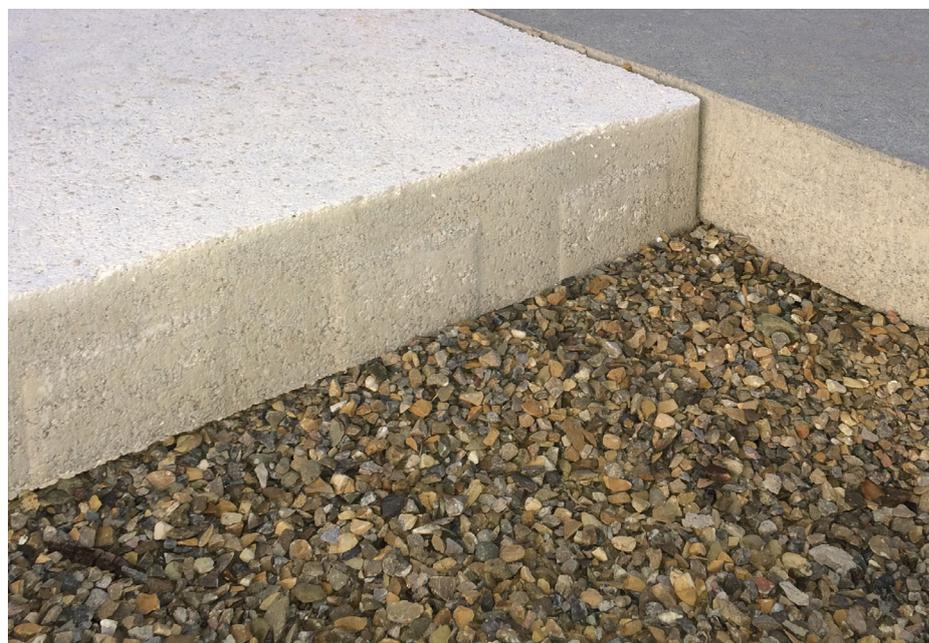
Particolare dello strato di allettamento di posa.
