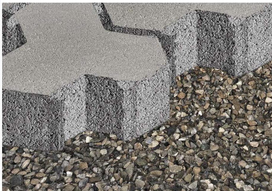
Particolare dello strato di allettamento di posa.
