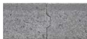
Particolare dell'incastro a posa eseguita
