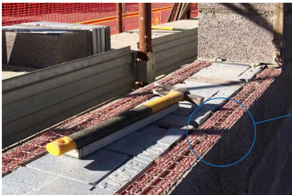
Reti metalliche flessibili per il rinforzo orizzontale delle murature, composta da una maglia di fili intrecciati di acciaio speciale, con rivestimento sintetico.
