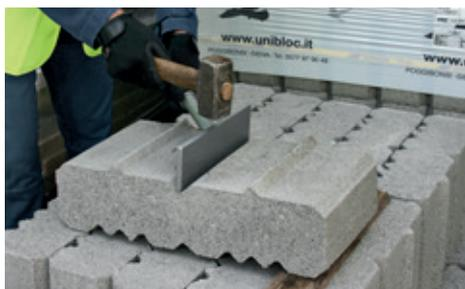
Operazione di spacco per ottenere due elementi per il montaggio singolo.
