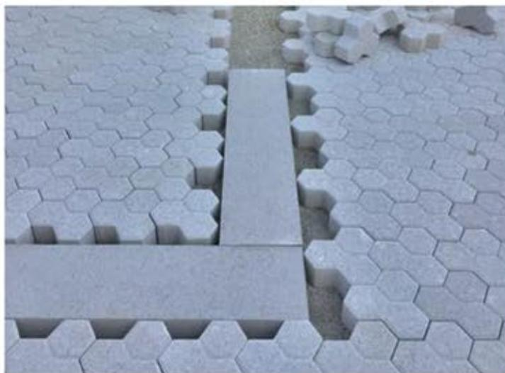
Lista tipo LST per separazione pavimentazione in masselli
