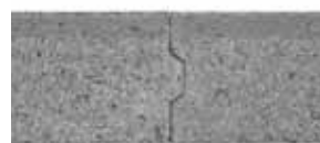
Particolare dell'incastro a posa eseguita
