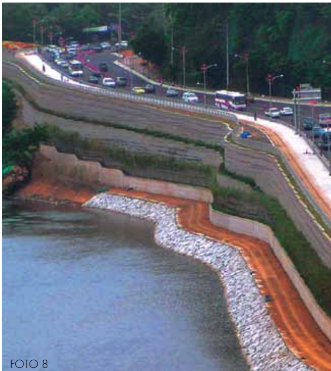
Foto 8: Chunsugyo, Saebeari (Corea del Sud) Rilevato autostradale realizzato con soluzione mista terre rinforzate- T-BLOCK
