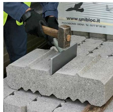
Operazione di spacco per ottenere due elementi per il montaggio singolo.
