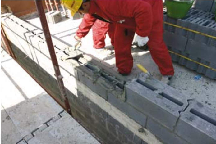
Posa secondo corso
