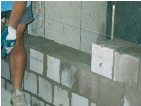
Muratura per prova acustica
