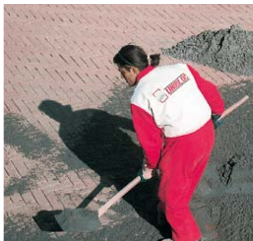
Stesura sabbia di intasamento
