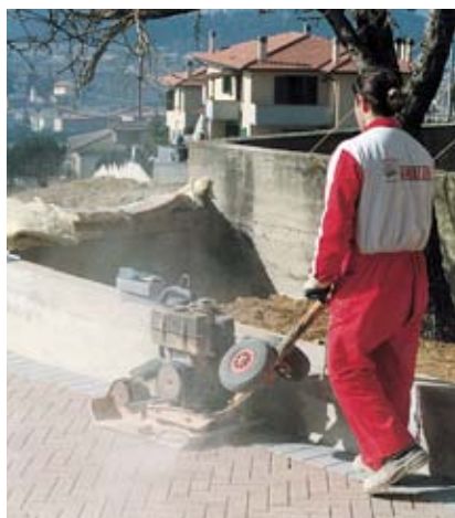
Compattazione della pavimentazione
