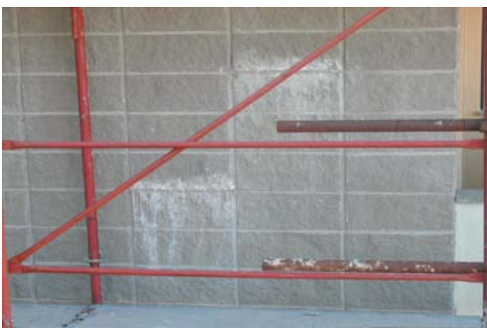
Efflorescenze dovute alla mancata protezione durante la posa
