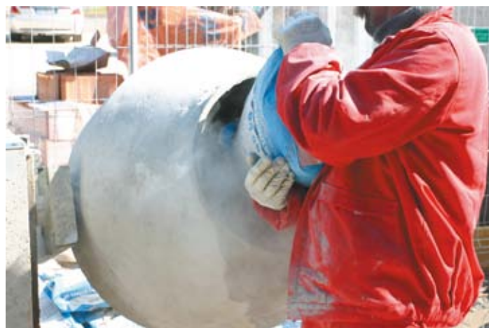
Preparazione della malta
