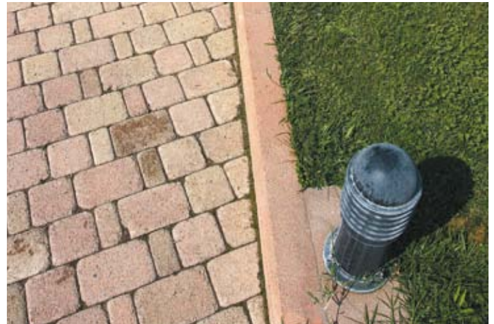
Montaggio pavimentazione a battuta sul cordolo
