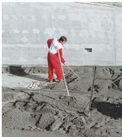
Stesura piano di posa
