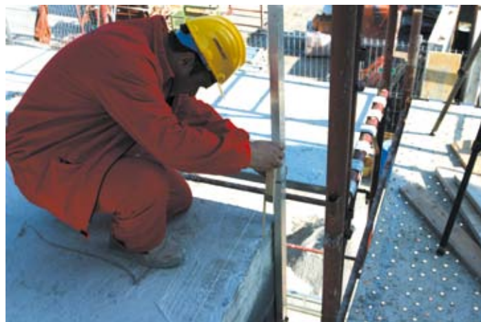
Verifica quota filo orizzontale
